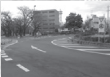
■環道の車線幅員減少 斜線のマーキングによって環道を完全な円形にする。また、幅員を狭め車両の走行の安定化を図る。
