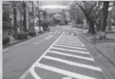
■並木通りの片側一車化 環道への導入部を一車線にし、横断歩道の距離を短くする。
