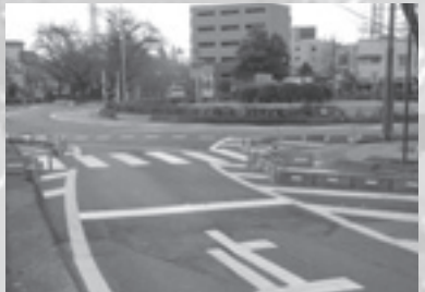
■環道への入口を改良 環道への導入方向を中央島に向け、直線的な流入を防ぎ速度の抑制を図る。
