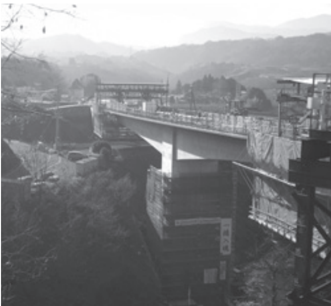
② 16号橋工事の様子
