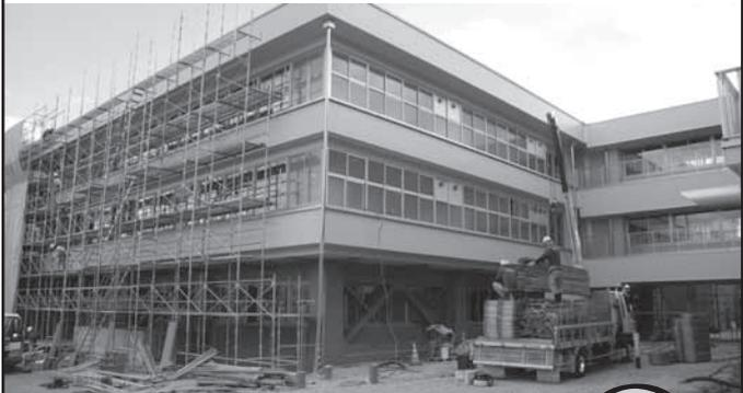
外壁の改修後足場が解体され、外観が見えるようになりました。新庁舎と同系の色調となり、窓のサッシは一部を残して入替え、省エネルギー化を図ります。
