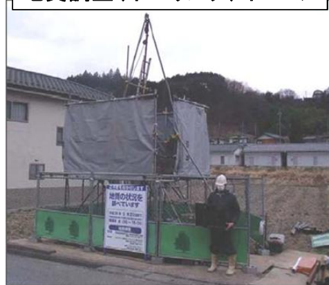
地質調査(ボーリング)イメージ
