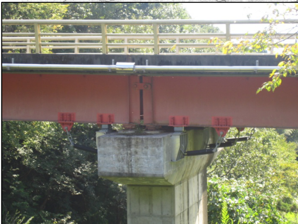
落橋防止装置
