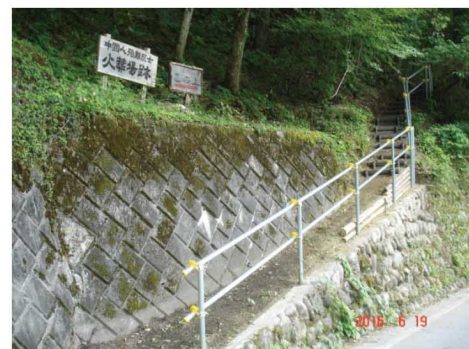
設置された階段と手すり(火葬場跡登り口)
