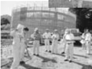
上郷第2配水池建設現場
