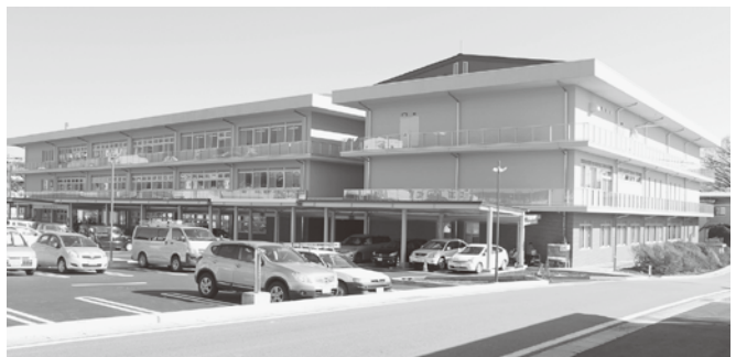
市役所新庁舎。右側が議場のあるB棟
