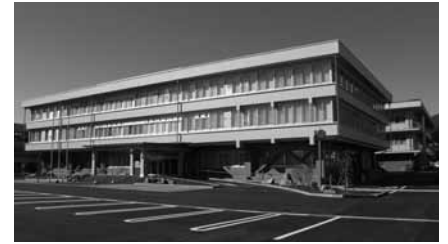
旧庁舎耐震改修工事 10億8,955万円 市民の皆さんが利用できる市民サロンや食堂を配置
