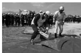
◀エンジンカッターを使った機動救助隊訓練
