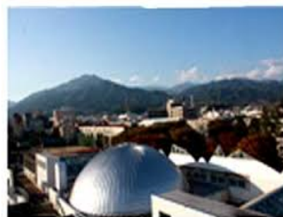
＜当館屋上のドーム＞
