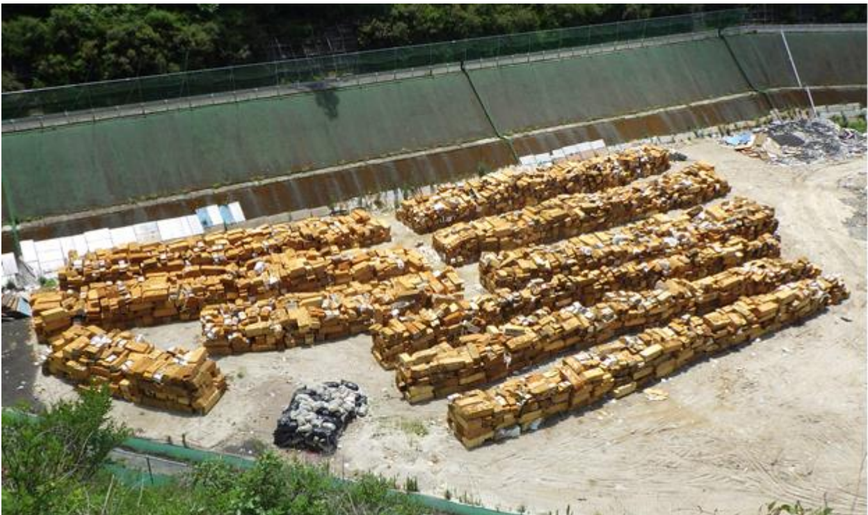
(断熱材ウレタンフォーム等の仮置状況 (グリーンバレー千代))
