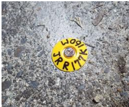
幅杭設置例 (鋳)
