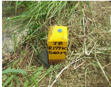
幅杭設置例 (杭)
