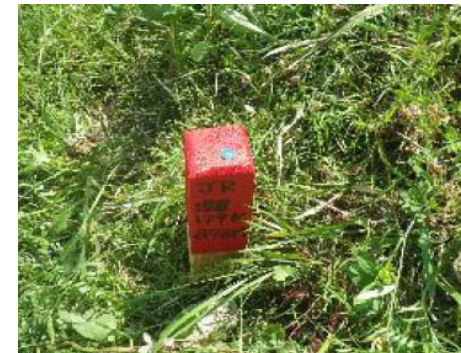
中心杭設置例 (杭)
