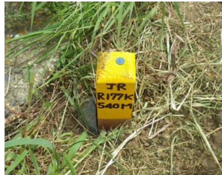
幅杭設置例 (杭)
