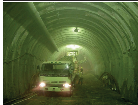
吹付コンクリート
