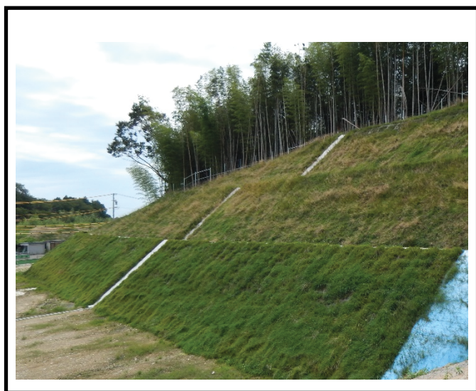
切土法面等の緑化
