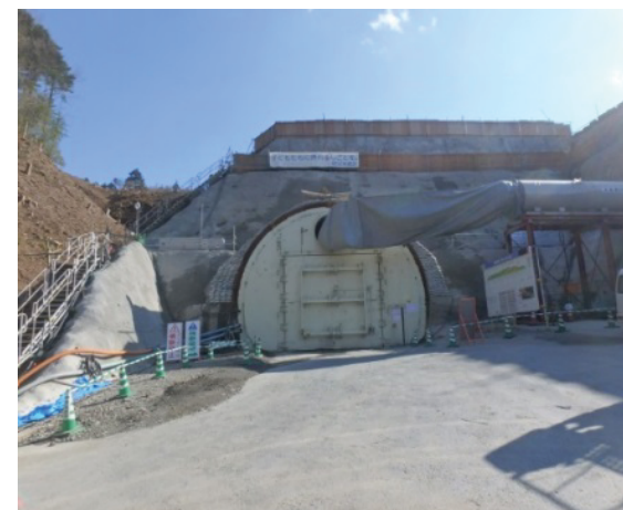
防音扉の設置
