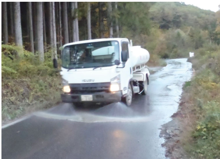
道路の散水・洗浄状況
