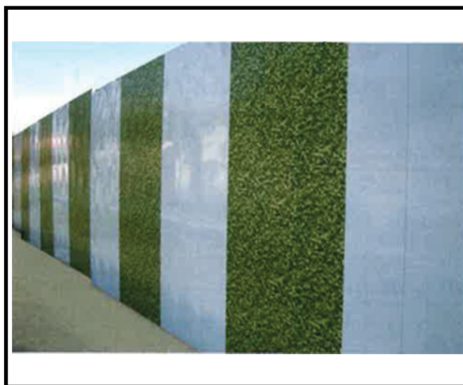
仮設物の色合いへの配慮(仮囲い)
