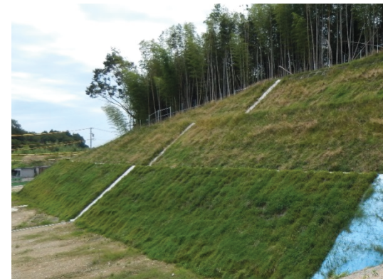
切土法面の緑化
