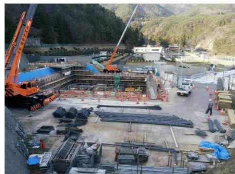
妙琴浄水場施工状況
