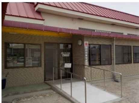
【歴史研究所の移転（旧鼎東保育園を改修）】
