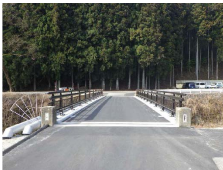
橋梁長寿命化修繕
