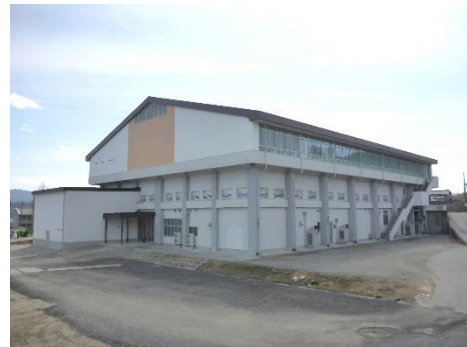
第Ⅱ期工事 外観
