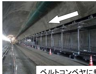
ベルトコンベヤに乗せて外まで運び出す
