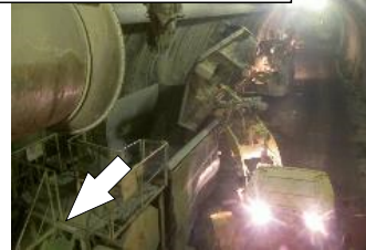
ベルトコンベヤで運搬
