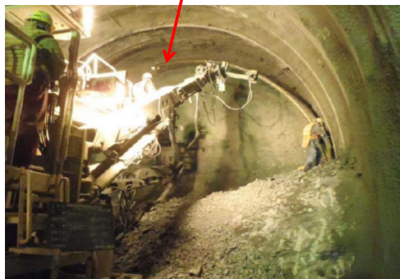
※地山状況により施工を実施
