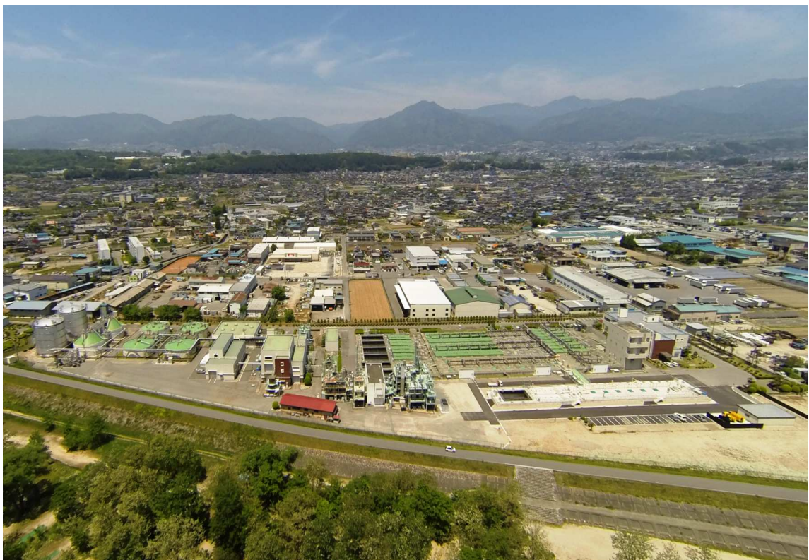
松尾浄化管理センター全景
