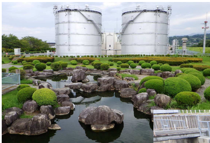
松尾浄化管理センター かまいわ公園 (汚水処理後放流水による管理池)
