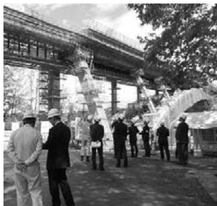
仮称 天龍峡大橋 建設現場
