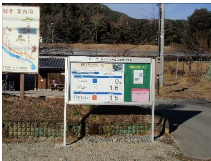
安全掲示板の設置状況(県道飯田南木曾線)
