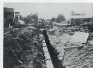
並木通りのヒューム管埋設工事
