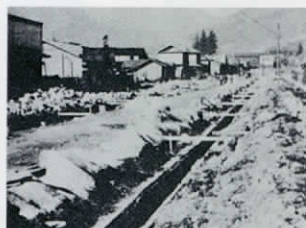
復興工事中の通り町
