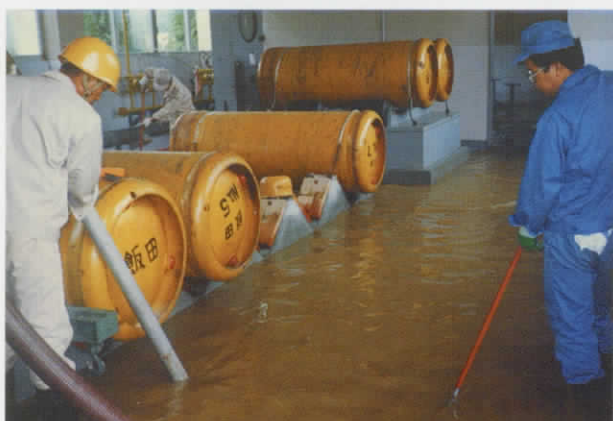
9/30 浸水 塩素ポンプ室内清掃作業
