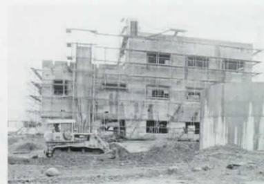
建設中の汚泥処理棟
