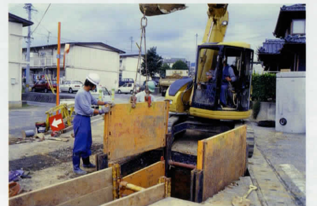
▲管渠築造工事中の竜丘処理区
