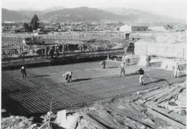
最初沈殿池築造工事
