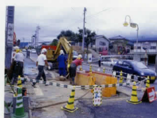
工事風景：伊賀良
