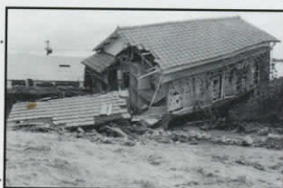
36災の被害甚大
