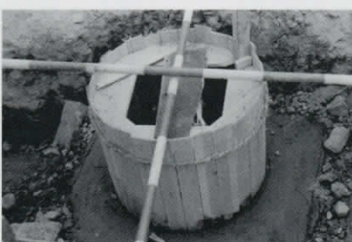
マンホール復旧工事
