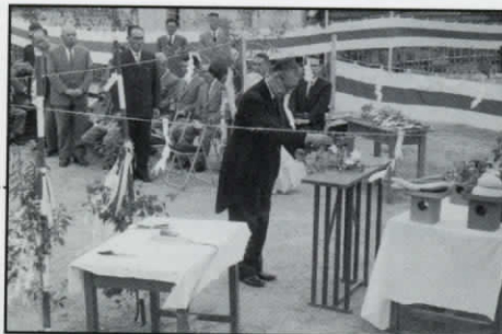
別府下水処理場竣工
