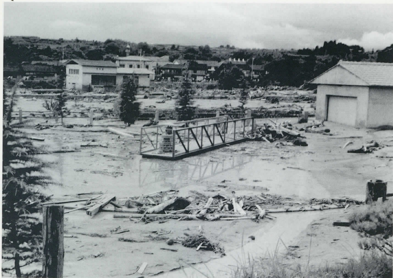
土砂に埋まった処理場
