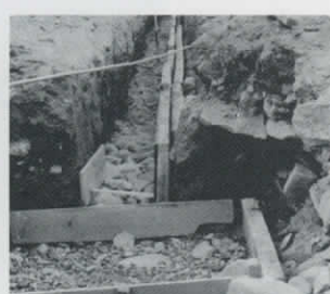
下水道の復旧
