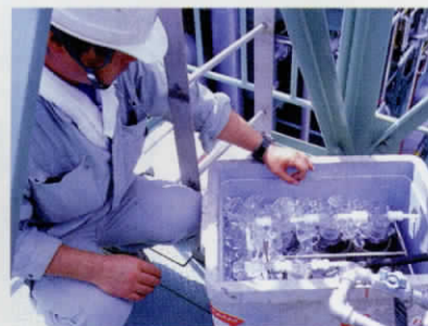
焼却施設での作業風景
