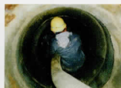
マンホール洗浄作業
