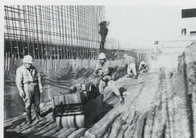
エアレーションタンク工事
