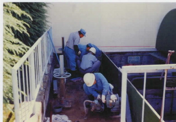
9/29 マイクロストレーナー モーター 減速機オーバーホール
