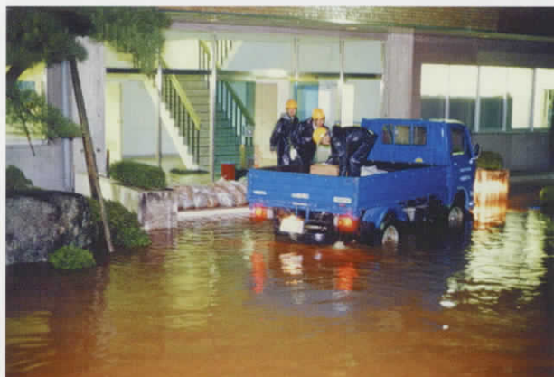
9/28 処理場正面玄関前 浸水450mm
