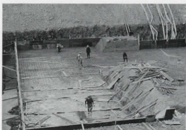
沈砂池築造工事
