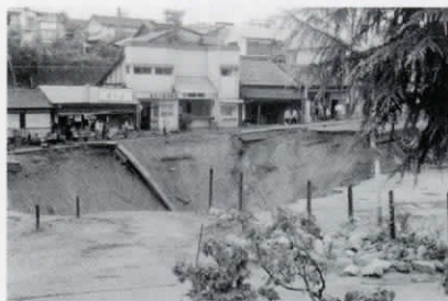
東中央通りの崩落
