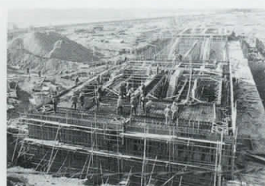
建設中の水処理施設
