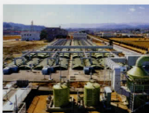
松尾浄化管理センターの1系列時期
