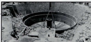
処理場工事着工
