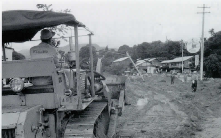
重機による復旧作業の様子
