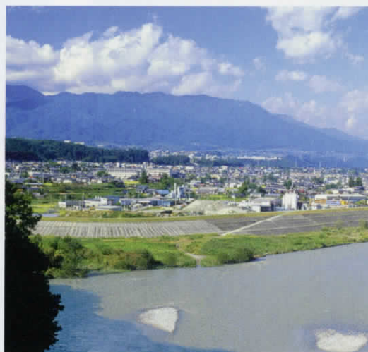
現在では、当時のおもかげはなく堤防をはじめ護岸整備がなされた。
