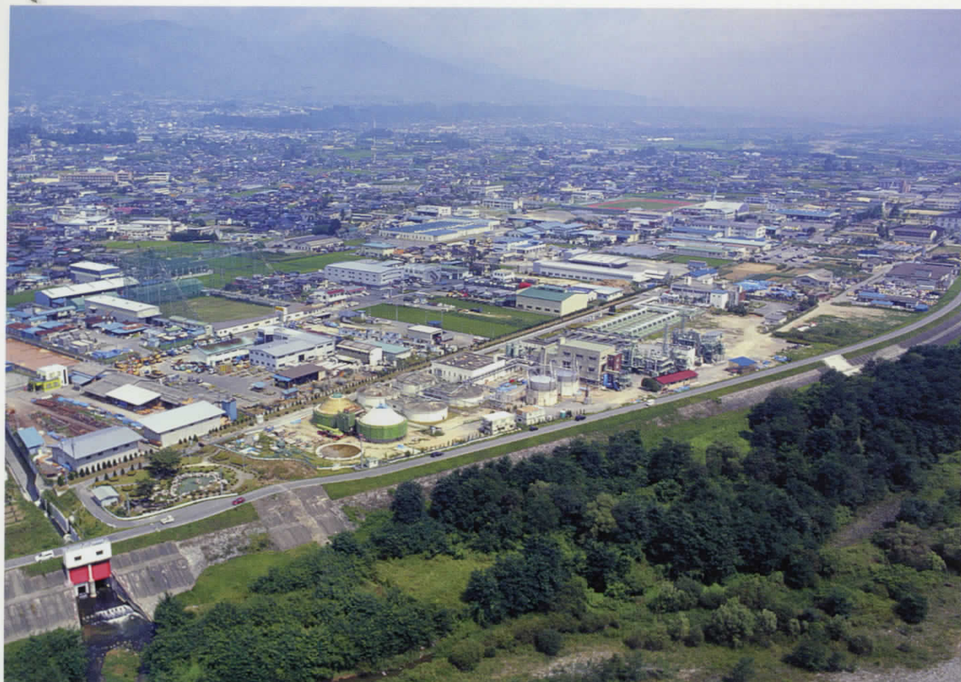
松尾浄化管理センター：上空から撮影
