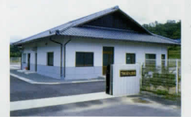
▲農業集落排水処理場(下殿岡処理区)
