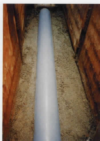
下水道用硬質塩化ビニール管布設状況
