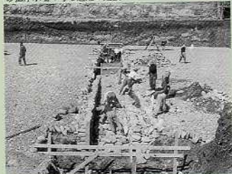
砂払浄水場4号ろ過池の建設
