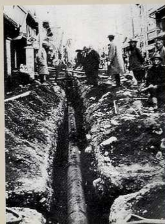
配水管の布設風景 (現在の銀座にて)
