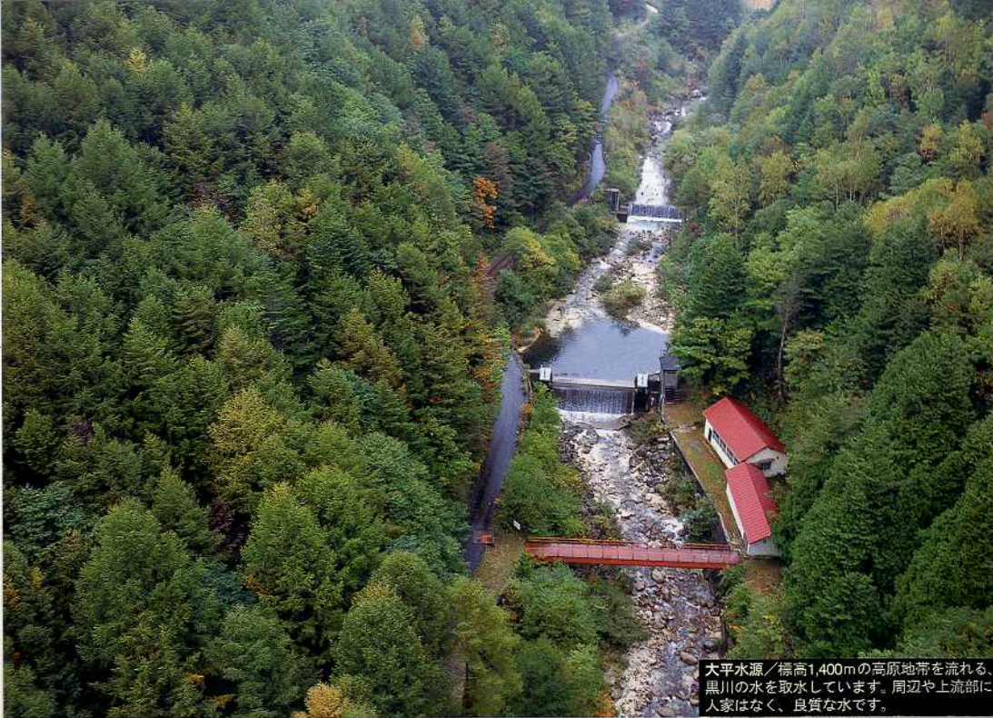
松川水源 / きれいな水の流れる松川をダムでせきとめ、ここから妙琴浄水場の水源地まで導水しています。
