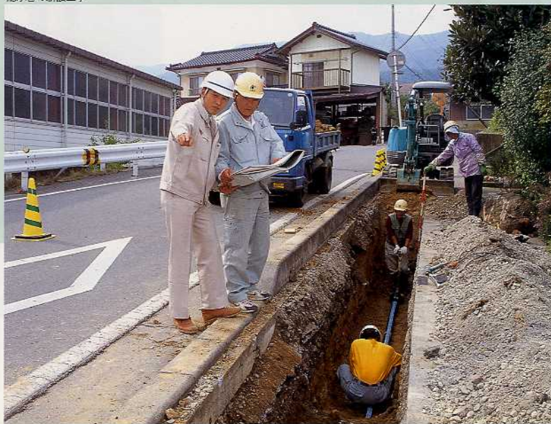
配水管の新設工事
