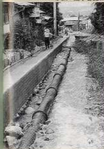
砂払・配水管露出
