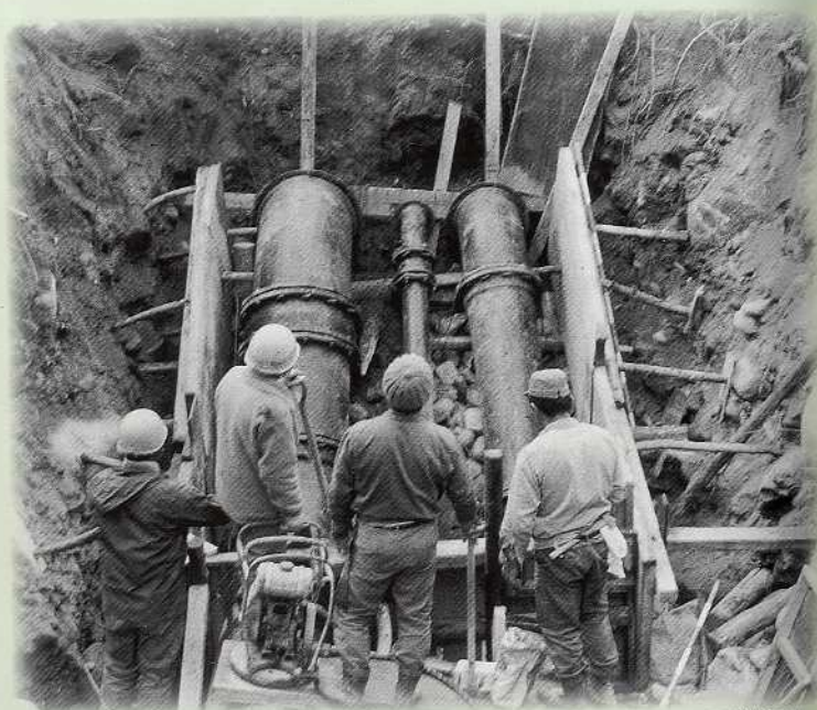
配水管布設工事
