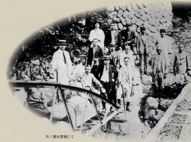
市ノ瀬水管橋にて
