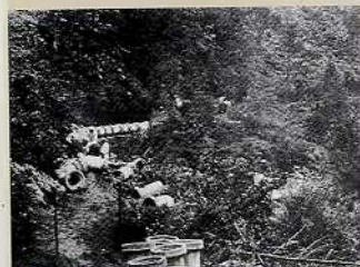
上/上水道の完成を伝える当時の新聞 下/大平での導水管布設風景
