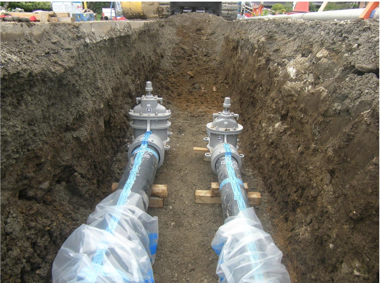
配水管布設替工事実施状況（平成26年度 上郷配水管布設替工事）
