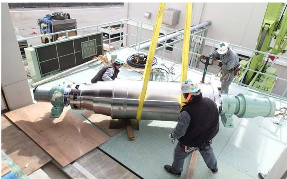
松尾浄化管理センター 長寿命化対策事業（汚泥脱水機、平成 26 年度施工）
