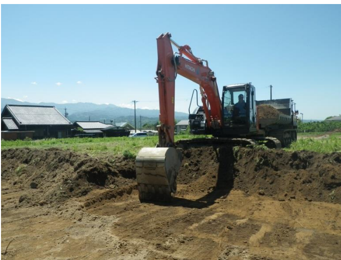
重機掘削(黒色が畑畝、黄色が洪水砂)
