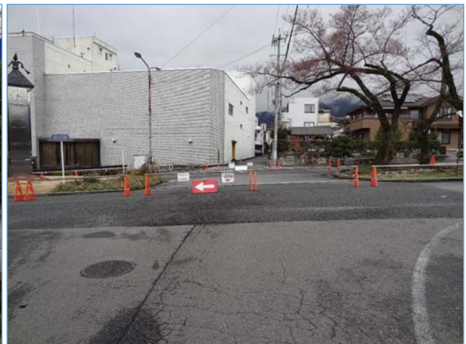
中央分離帯 開口部閉鎖状況 伝馬町1・吾妻町交差点（飯田市公民館上）
