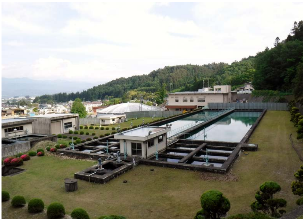
浄水池・管理棟を建設中の妙琴浄水場
