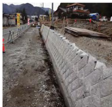
①区間施工状況
