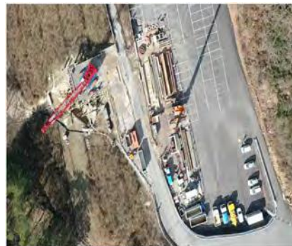
施工状況①
