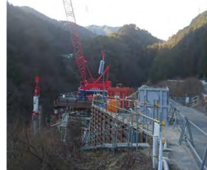
施工状況②
