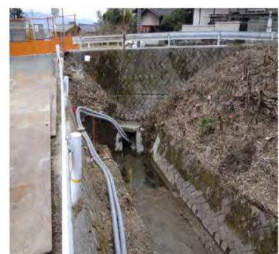
円悟沢川施工状況
