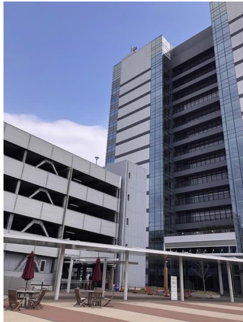
一宮市役所2014年建築
