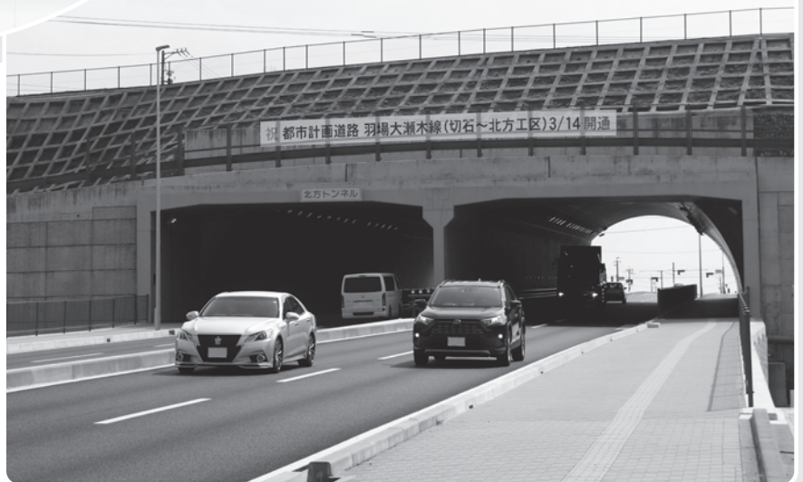
北方トンネルを含む鼎切石～北方間が開通した羽場大瀬木線
