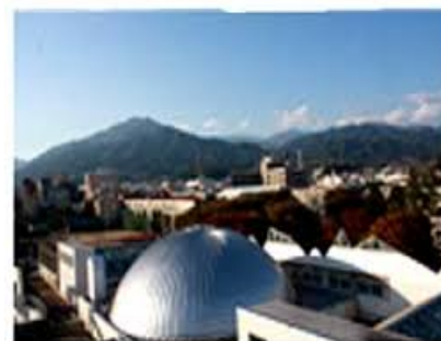
<当館屋上のドーム>
