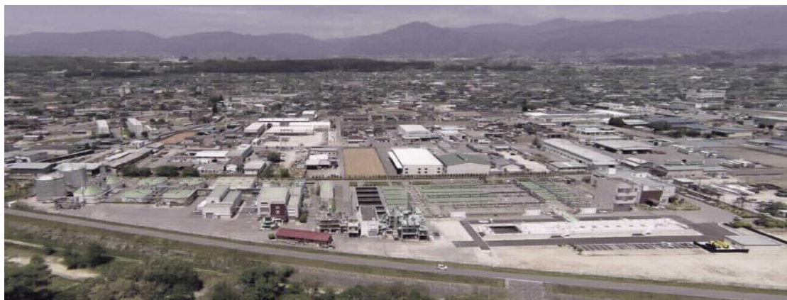
【松尾浄化管理センター全景】
