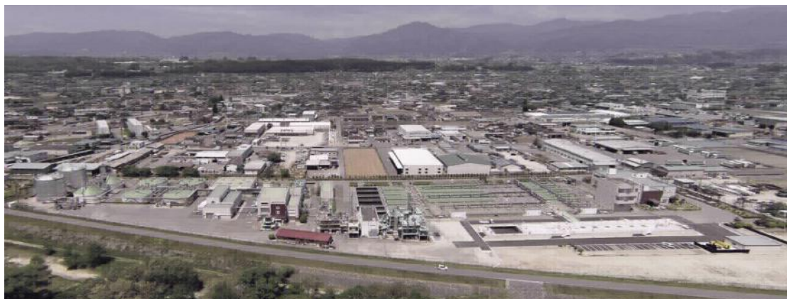
【松尾浄化管理センター全景】
