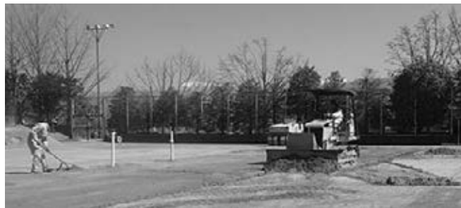
重機により表層を耕して整地
