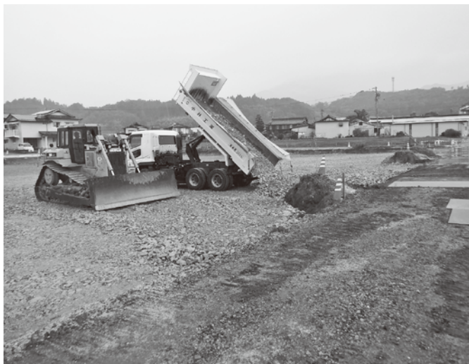
▲ 工事が進む「丹保・北条地区代替地予定地」
