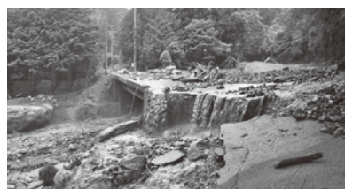
▲市道上村102号線の災害現場
