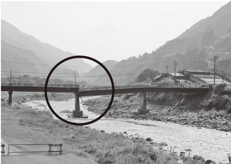
▲豪雨によって橋桁がずれた状態の「中橋」
