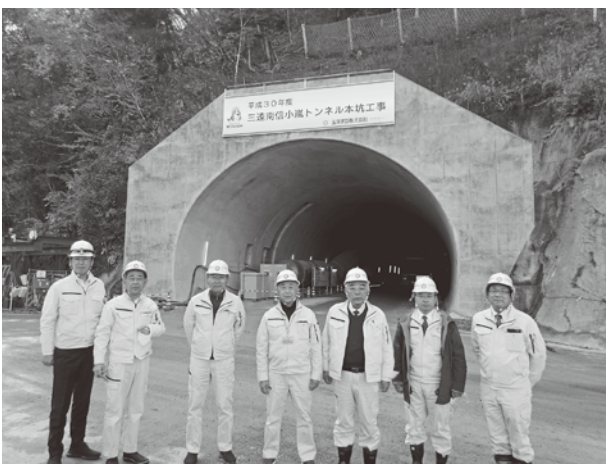
▲順調に進むトンネル工事 三遠南信自動車道青崩峠道路の開通に期待
