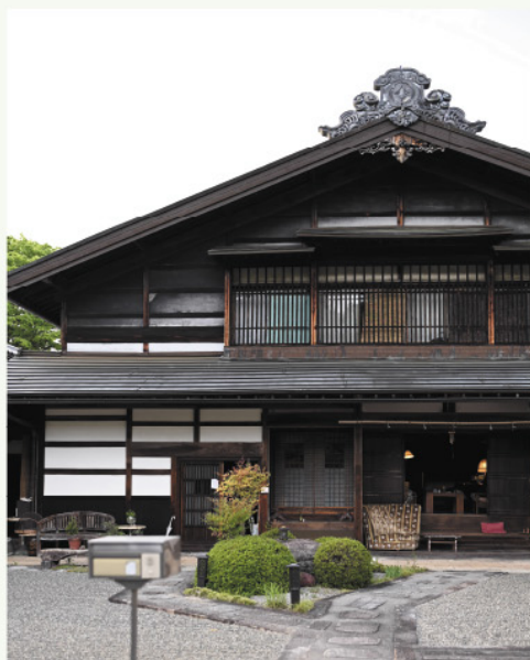
下久堅九如亭(明治初期の本棟造の古民家)
