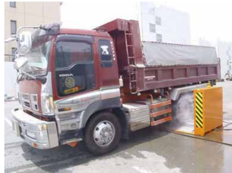
タイヤの洗浄状況
