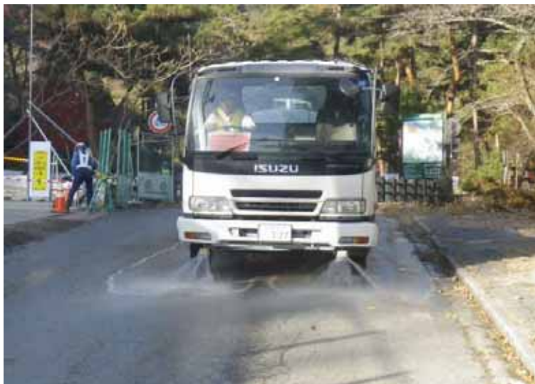
道路の散水・洗浄状況
