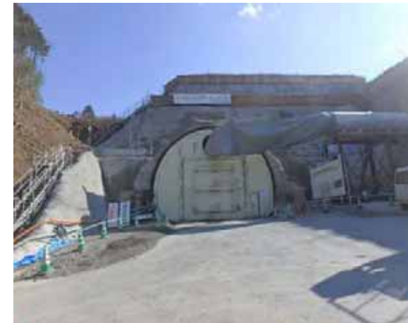
防音扉の設置
