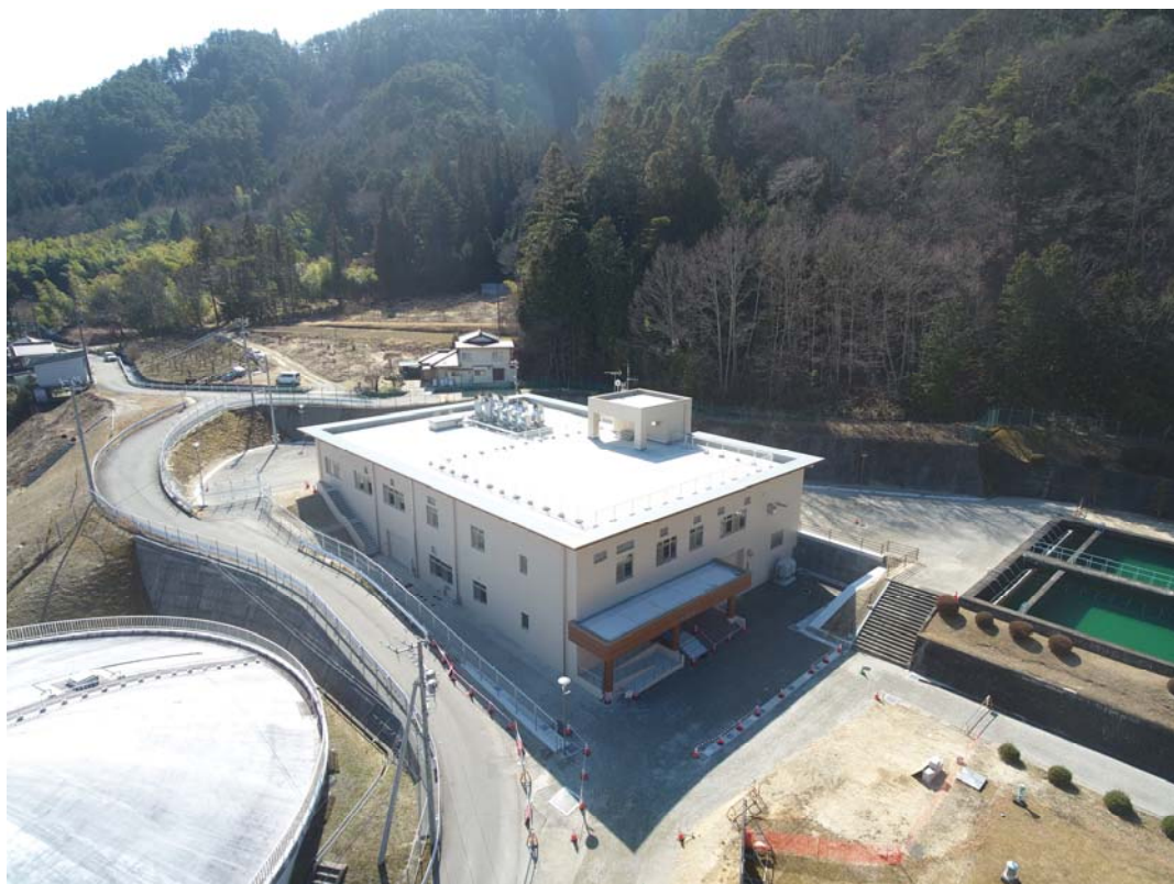
竣工した妙琴浄水場新管理棟
