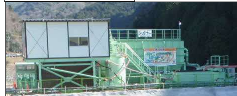
工事排水の処理設備
