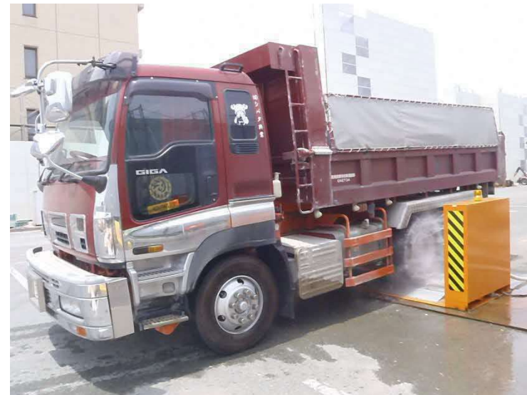
タイヤの洗浄状況
