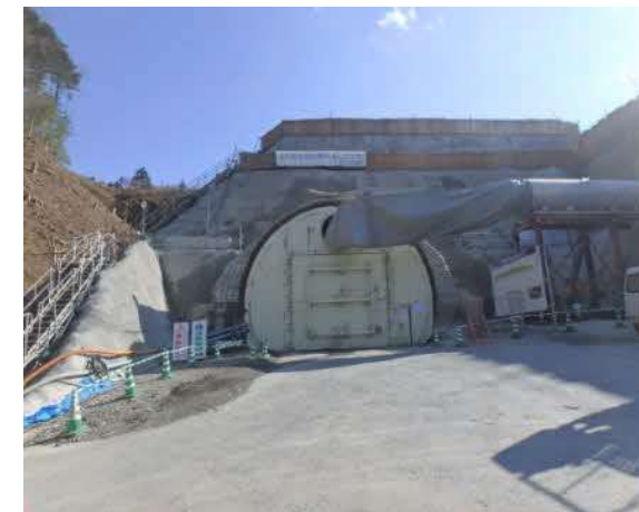
防音扉の設置
