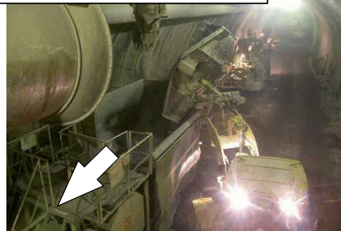
ベルトコンベヤで運搬
