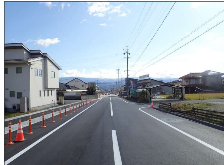
区間6工事完了後
