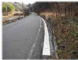
(通学路の側溝に蓋をし、歩行空間を確保した事例)
