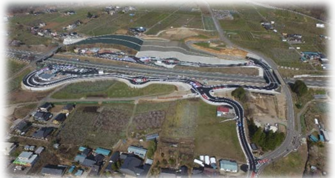
〈座光寺スマートインターチェンジ〉
