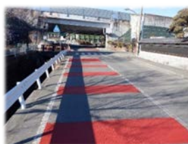
(通学路の横断歩道手前をカラー舗装し注意喚起を促した事例)
