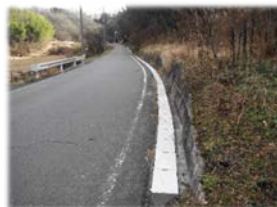
(通学路の側溝に蓋をし、歩行空間を確保した事例)
