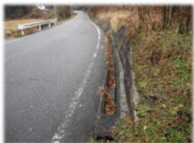
(通学路の側溝に蓋をし、歩行空間を確保した事例)
