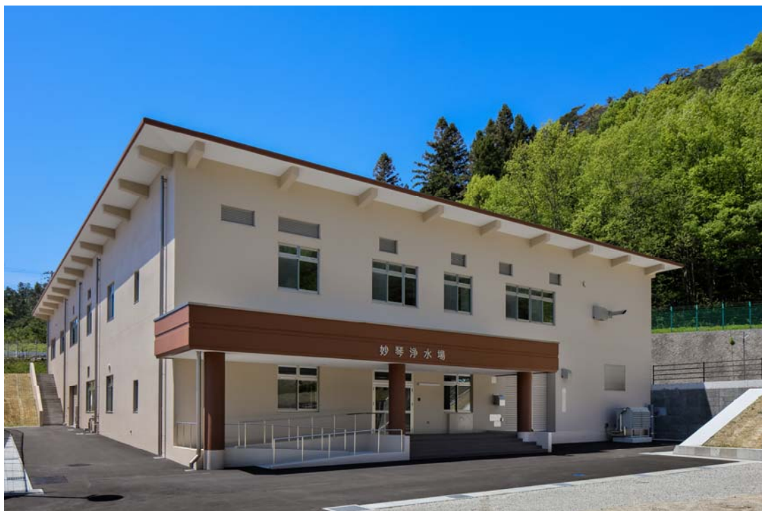
妙琴浄水場新管理棟（令和3年3月竣工）
