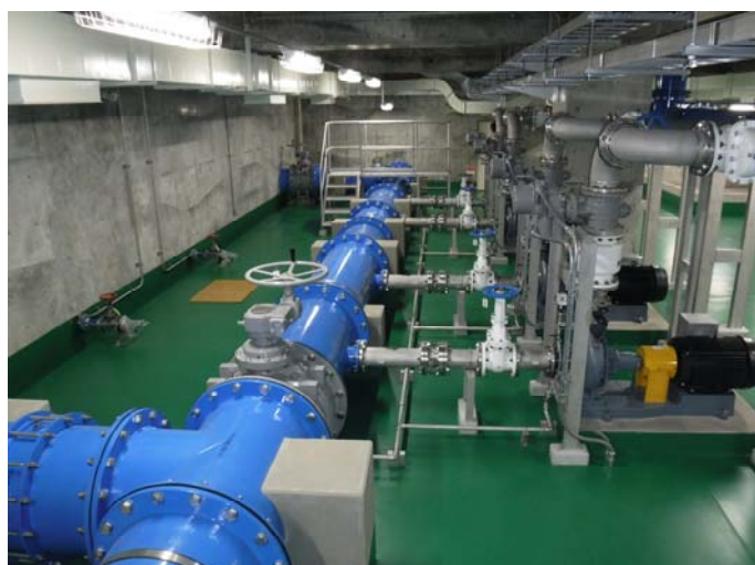
地下2階 浄水池送水ポンプ
