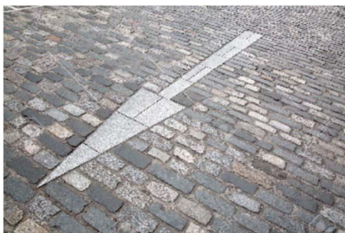
舗装材張替えによるサイン
