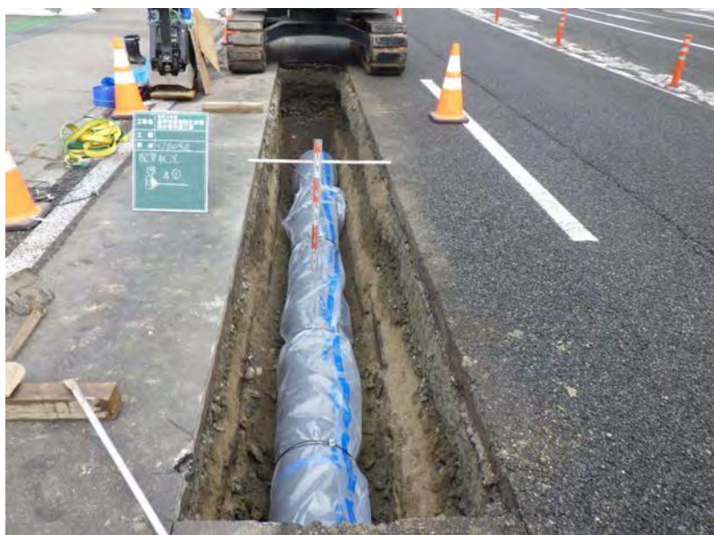
送水管 ダクタイル鋳鉄管 GX 型 \phi 400 (砂払浄水場から下黒田配水池)
