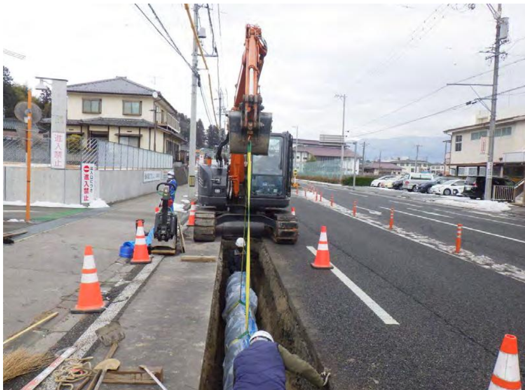
基幹管路耐震化事業 東野
