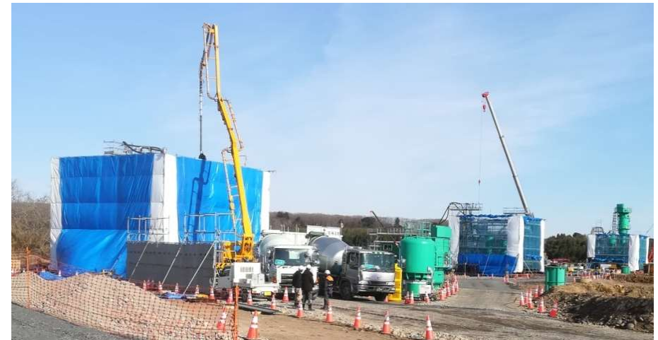
⑥橋脚部コンクリート打設
