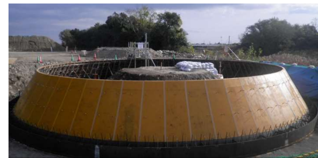
①作業室構築
