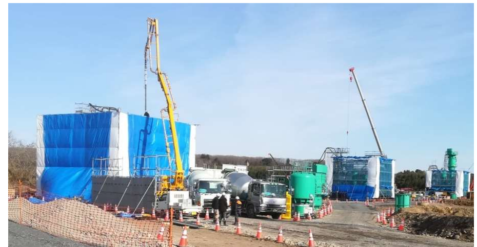
⑥橋脚部コンクリート打設
