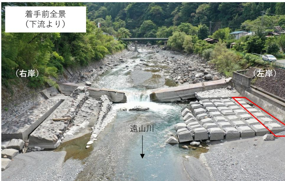
左岸側護岸に既設コンクリート擁壁が確認されたため、張りコンクリート工を減とし、擁壁を巻き込むよう垂直壁工・水叩工の形状を変更とする。
