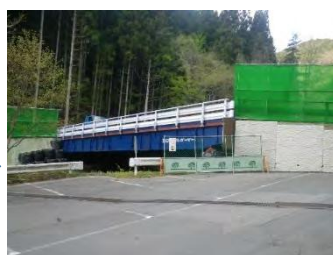
閼沢 (くらがりさわ) 川 工事用仮橋設置 (済)
