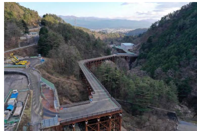
施工ヤード造成
